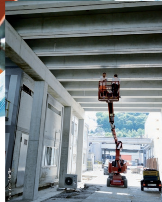
Verstärkung: das Hallendach muss für eine 40 Tonnen schwere Klimaanlage vorbereitet werden.
